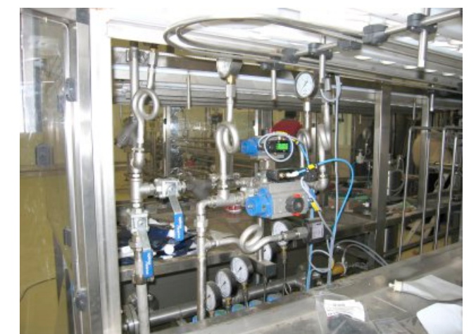
Poste de distribution de vapeur pour ligne aseptique
